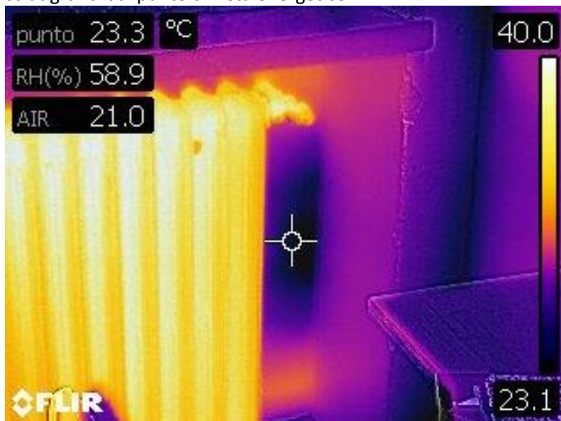
Figura 2.2 – Immagine termografica nicchia sottofinestra
