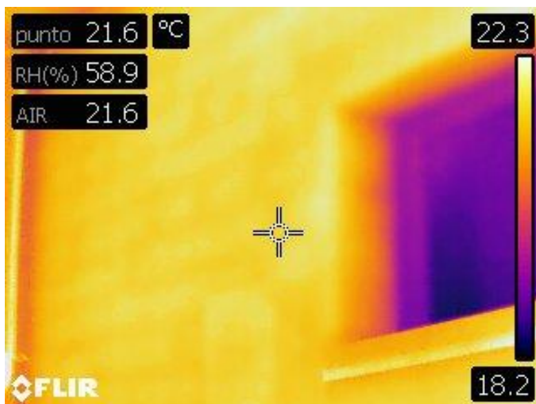
Figura 2.3 – Immagine termografica parete perimetrale
